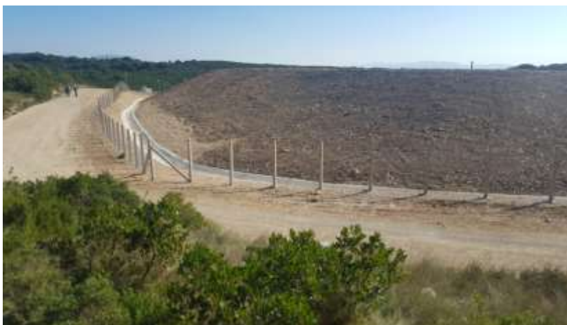
Ograda odlagališta i obodni kanal
